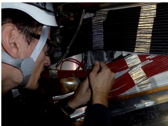
Slika 2: Vgradnja novega diamantnega detektorja DBM (Diamond Beam Monitor) v spektrometer ATLAS, ki bo omogočal natančne in takojšnje meritve porazdelitve trkov grušč protonov v trkalniku LHC
