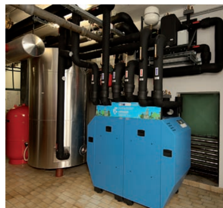
Slika 4: Adsorpcijski hladilni sistem z zalogovnikom toplotne energije (avtor fotografije M. Smerke)
