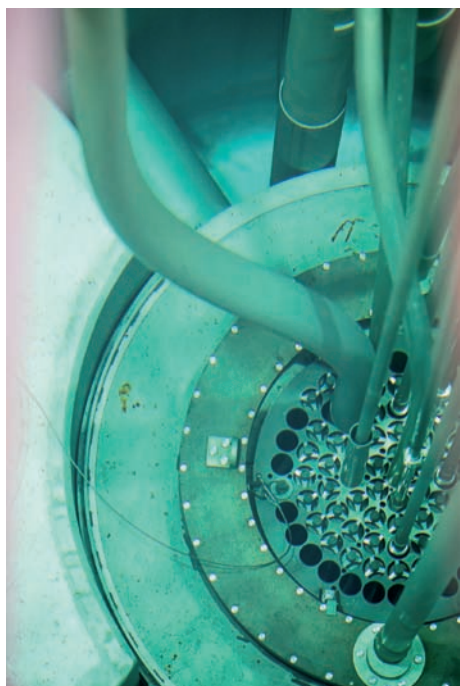
Slika 2: Sredica reaktorja
