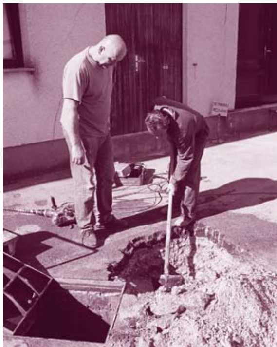
Slika 2: Dela pri južnem prizidku - Stane Cvelbar in Janko Gerjol
